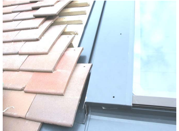
Figure 27 Fix edge flashing
